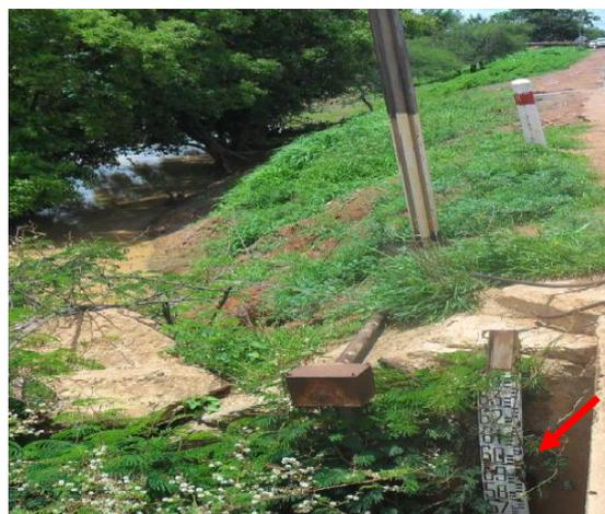
Figure 1.47 : Echelle limnimétrique E 1-7 et support IPN 80 endommagés
