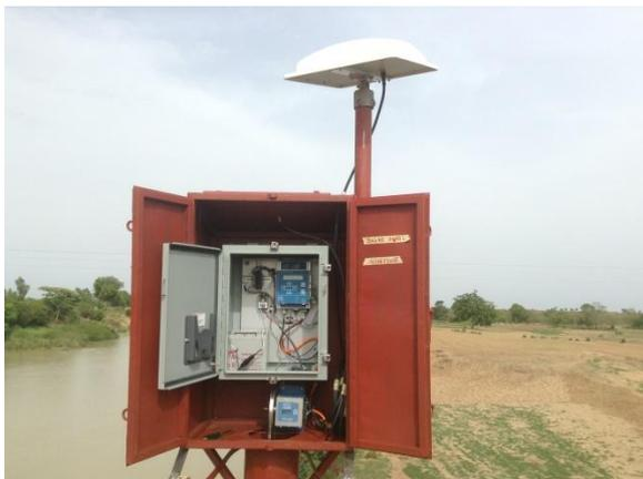
Plateforme de collectes données hydrométriques SUTRON à Télétransmission Satellitaire
