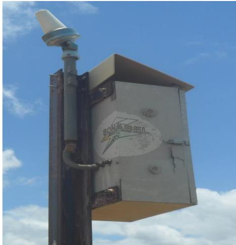
Figure 1.48 : Coffret de la PCD fissuré et plaque solaire absente
