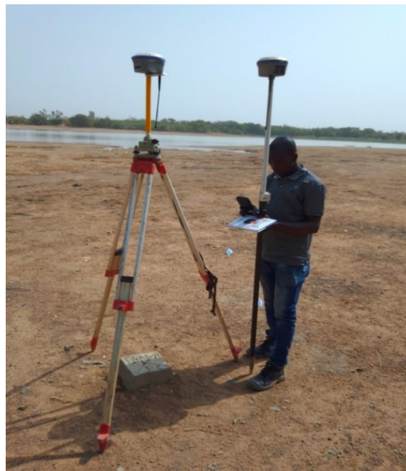
Figure 6 : Illustration des travaux topographiques
