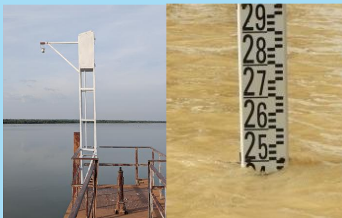
Station hydrométrique automatique et Échelle limnimétrique — suivi des niveaux d'eau des retenues stratégiques
